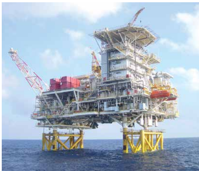
Hình 4. Giàn khai thác mỏ khí Lan Tây, Lô 06-1: Khí khai thác từ 5 giếng ngầm được hoàn thiện với cây thông khai thác ngầm, qua cụm phân dòng Lan Tây manifold, qua đường ống dẫn khí 2 pha được đưa về giàn Lan Tây.
